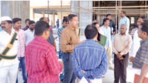
భవన నిర్మాణ పనులను పరిశీలిస్తున్న కలెక్టర్ రాజుధిషా
